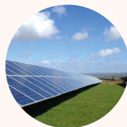
Pannelli I pali in acciaio sono installati a 1,5 m di profondità.
