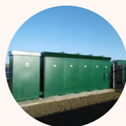
Inverter Trasforma la corrente continua (DC) in corrente alternata (CA).
