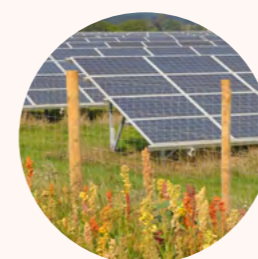
Recinzione per gli animali In genere si trovano a 5 m dal confine interno dell'impianto.
